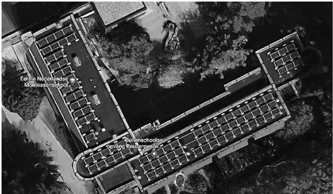
De panelen van de Zonnevogel Coöperatie op het dak van de Eerste Nederlandse Montessorischool aan de Laan van Poot
